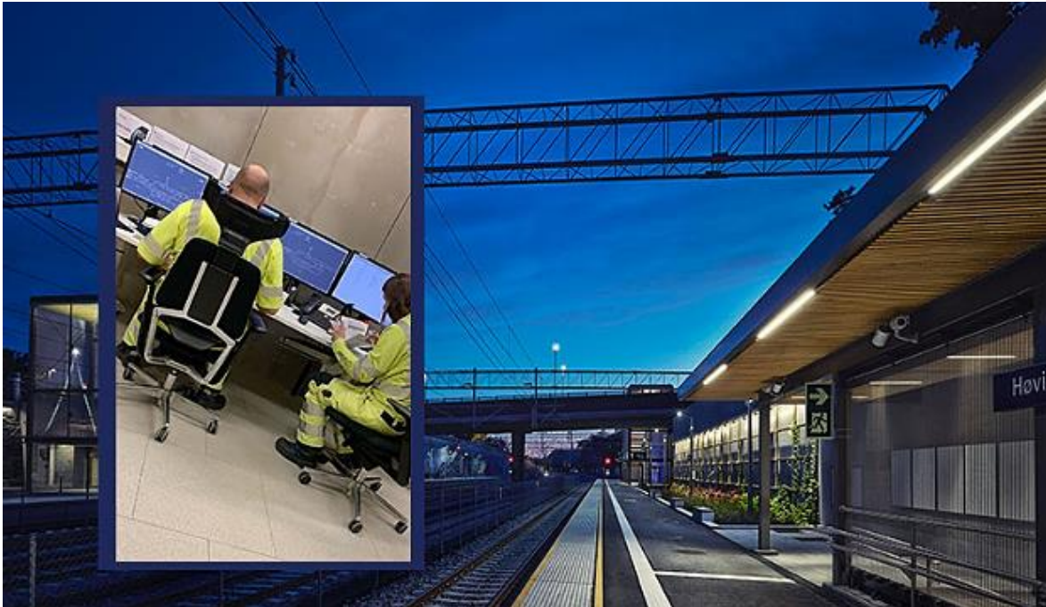
Bilde tekst: Arkivfoto fra Høvik stasjon og et bilde tatt under oppraderingen. Foto: Tomasz Maiewski/Bane
