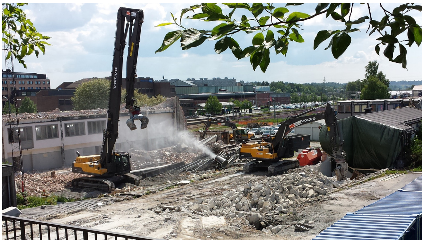
Jernbaneverkets driftsbygninger på Ski stasjon ble sommeren 2014 revet for å gjøre plass til teknisk bygg. Litt lenger sør vil det bli bygget en undergang. Vegetasjonsrydding starter i desember 2015. Foto: Jernbaneverket
