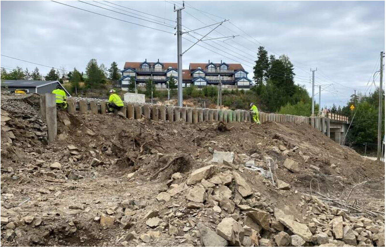
Stålpælene ved jernbanebrua vil være et trygt fundament for en ny og høyere jernbanebru over Stasjonsveien. Foto: Halldis Skogen, Bane NOR.
