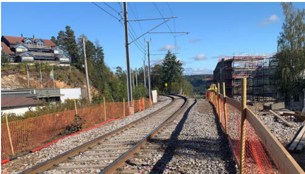
Jernbanebrua over Stasjonsveien skal byttes ut. Her blir det arbeid med fundamentering av ny bru i tiden framover. Foto: Aleksandras Belovas, Bane NOR.
