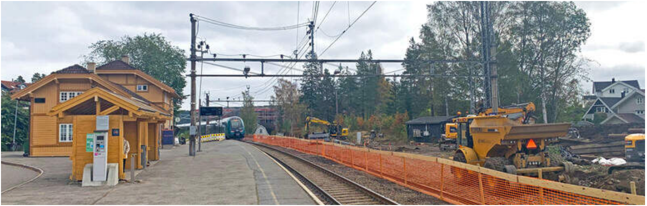
Det blir flere perioder med stans i togtrafikken mens vi bygger om Nittedal stasjon. Foto: Aleksandras Belovas, Bane NOR.
