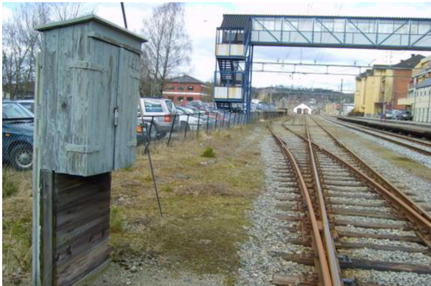
Mysen stasjon er en av fem stasjoner som blir oppgradert med ERTMS.
