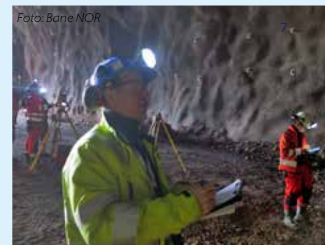
Basert på en geologisk kartlegging sikres tunnelen med sprøytebetong og bolter innvendig mellom sprengningene. Slik blir det sikkert å jobbe her og trygt å kjøre tog her.
