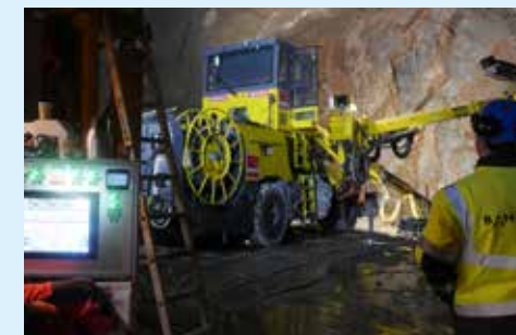
Basert på en geologisk kartlegging sikres tunnelen med sprøytebetong og bolter innvendig mellom sprengningene. Slik blir det sikkert å jobbe her og trygt å kjøre tog her.
