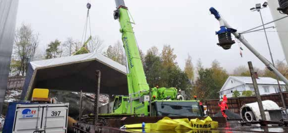
På Austad har vi gjort støydempende tiltak på ventilasjonsviftene, som sørger for ventilasjon til arbeiderne inne i tunnelen. Her ses et støyskjermende, spesialtilpasset telt bli løftet inn og plassert over viftene. Foto: Aleksander Thorbergesen
