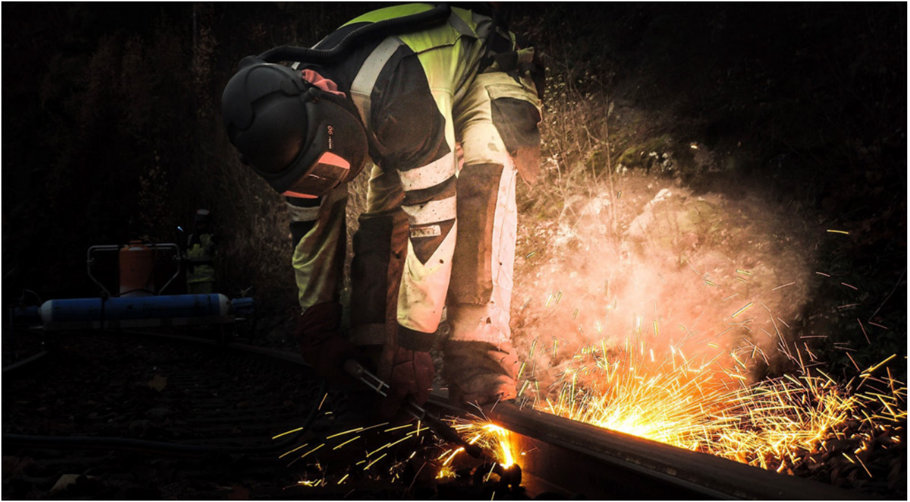
Den gamle banen kappes i 6 meter lange skinnestiger som fraktes til Oklungen for videre sortering. Foto: Terje Walle, Bane NOR
