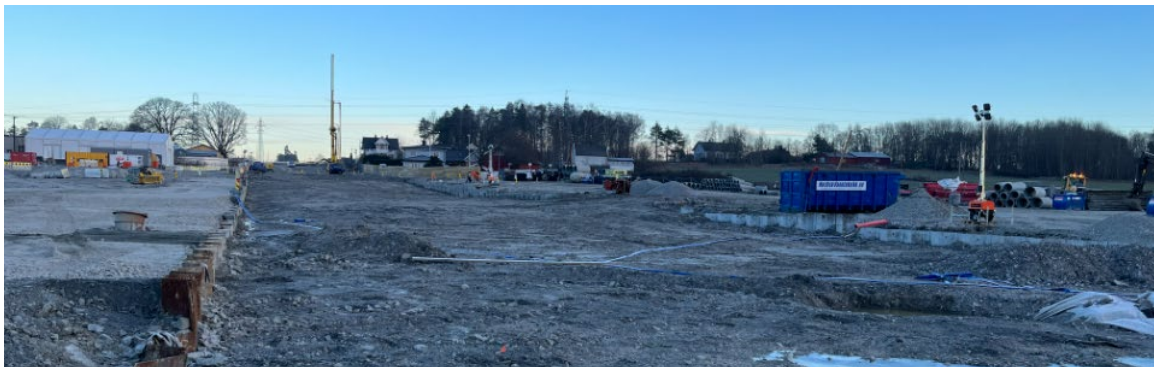
Figur 1. Larkollveien skal graves ut mellom spuntveggene for å etablere en kulvert.
