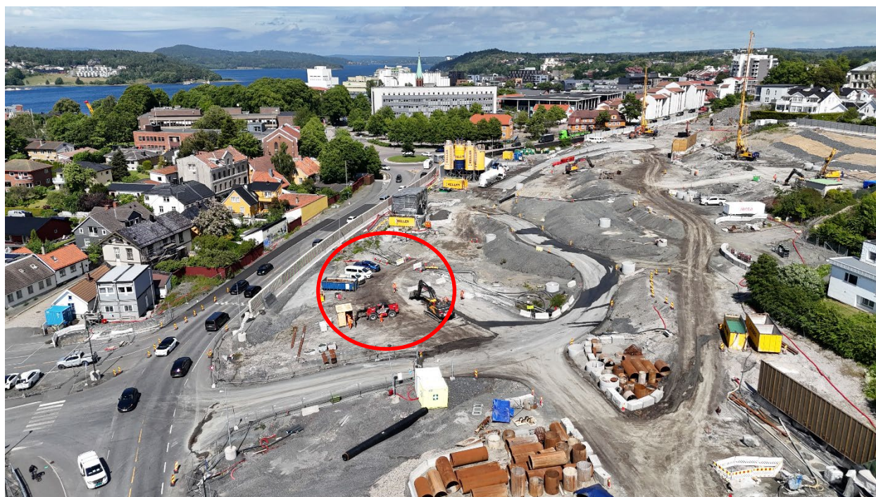
Spuntingen skal skje i dette området like ved Fjordveien og Nyquists gate. Dronefoto 19/6-26: Bane NOR.
