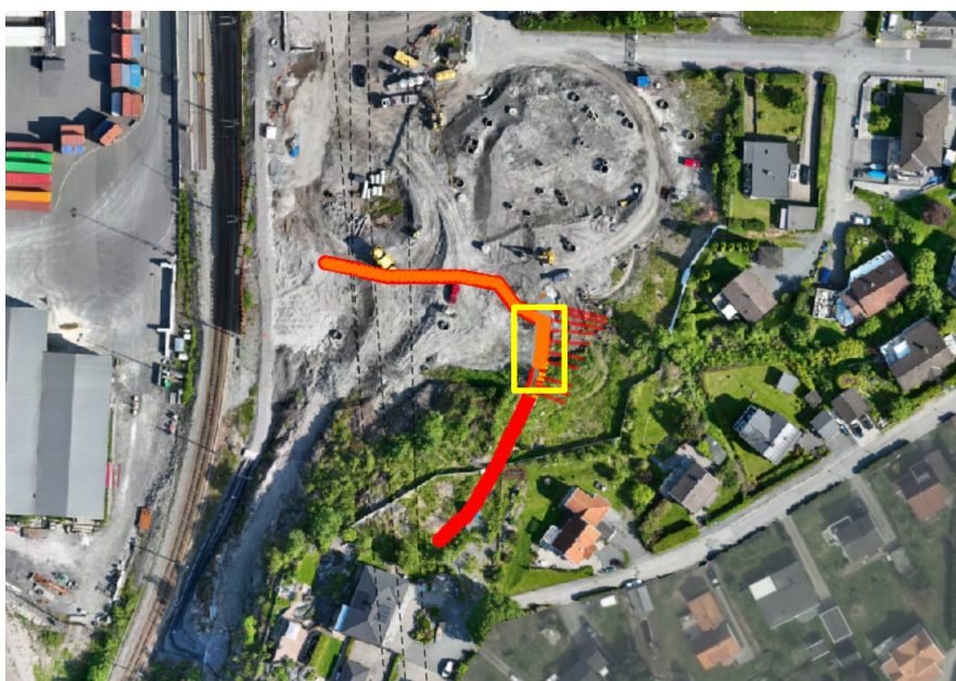
Figur 1. Spunting (innenfor gul firkant), boring (rød) og jetpeling (oransje) ved Kleberget.
