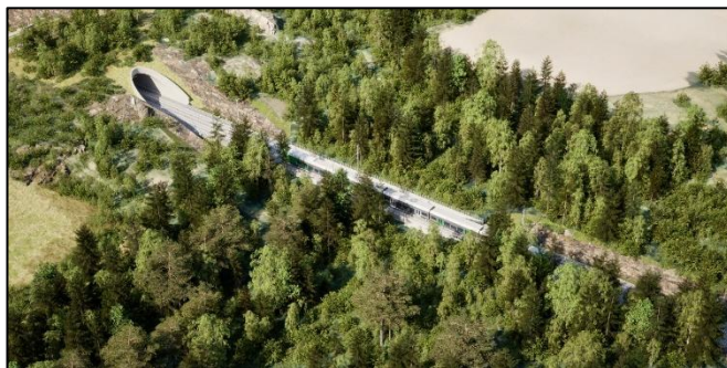
Figur 3-6: Illustrasjon av brukonstruksjon over myrlokaltet. Sett i nordvestlig retning. Betongplaten i brukonstruksjonen vil ligge på nivå med eksisterende terreng/myr. Myra er skogbevokst.
