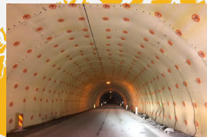
Vann- og frostsikring - rensk og bergsikring i tunneler i Nord Utførende: Implenia Norge AS Byggherre: Statens Vegvesen Byggetid: 10/2020 – 05/2022 Kontraktssum: 18,5 MNOK
