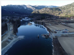
Fv. 2904 Austvoll bru Utførende: Implenia Norge AS Byggherre: Viken fylkeskommune Byggetid: 11/2020 – 01/2023 Kontraktssum: 64 MNOK
