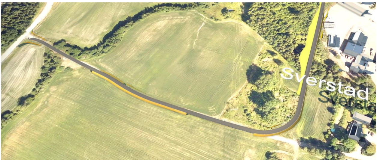
Figur 6-6. Adkomstvei forbi Sverstad gård. Noe jordbruksareal vil beslaglegges langs eksisterende vei og noe nytt areal vil gå tap der veien svinger mot nord.
