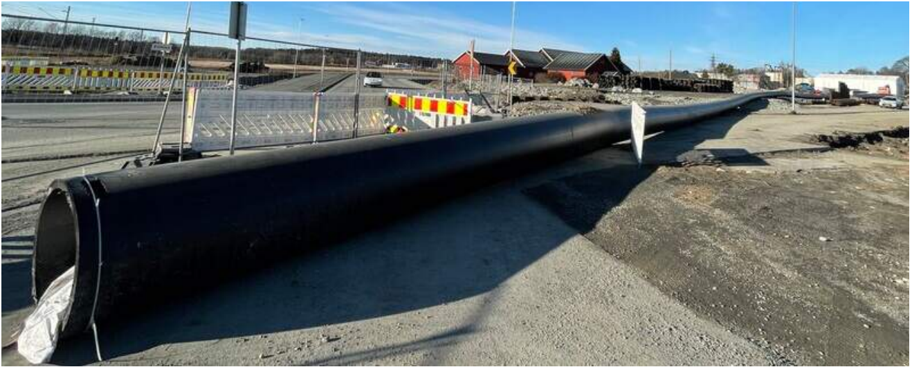
Det legges nye vann og avløpsledninger ved Larkollveien.
