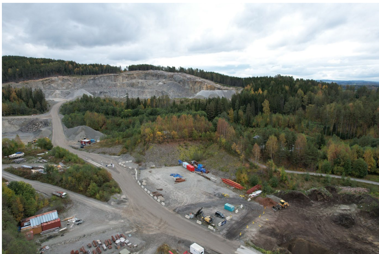
Figur 7 Tømten fjelltak (dronebilde Rambøll Sweco, oktober 2021)
