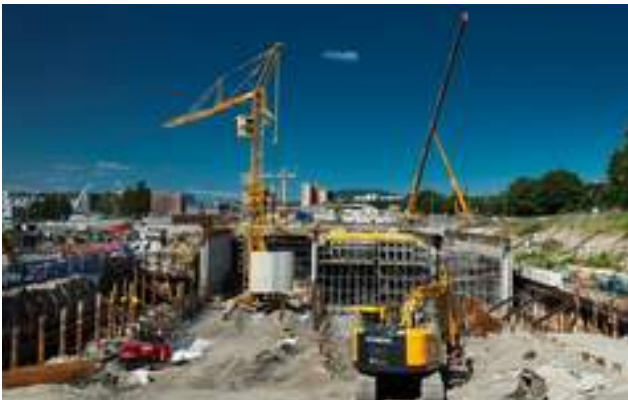
Arbeidet på Oslo-siden er meget avansert ingeniørkunst. Foto: Bane NOR
