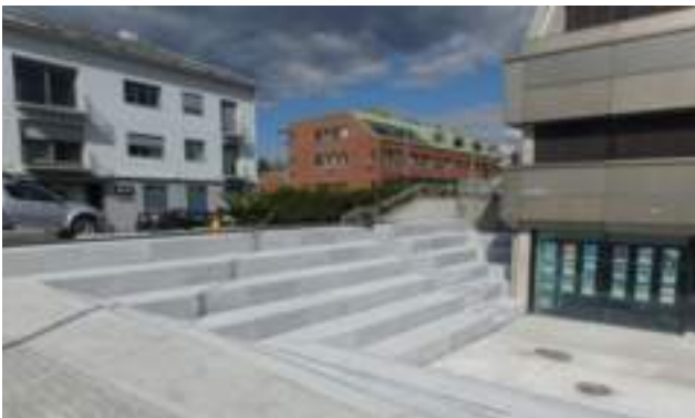
Den nye trappen og tribunen foran Jernbaneveien 4. Foto: Bane NOR
