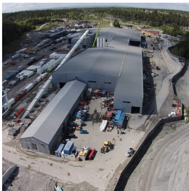
På Åsland demonteres bygninger og installasjoner og denne sommeren. Foto: Bane NOR
