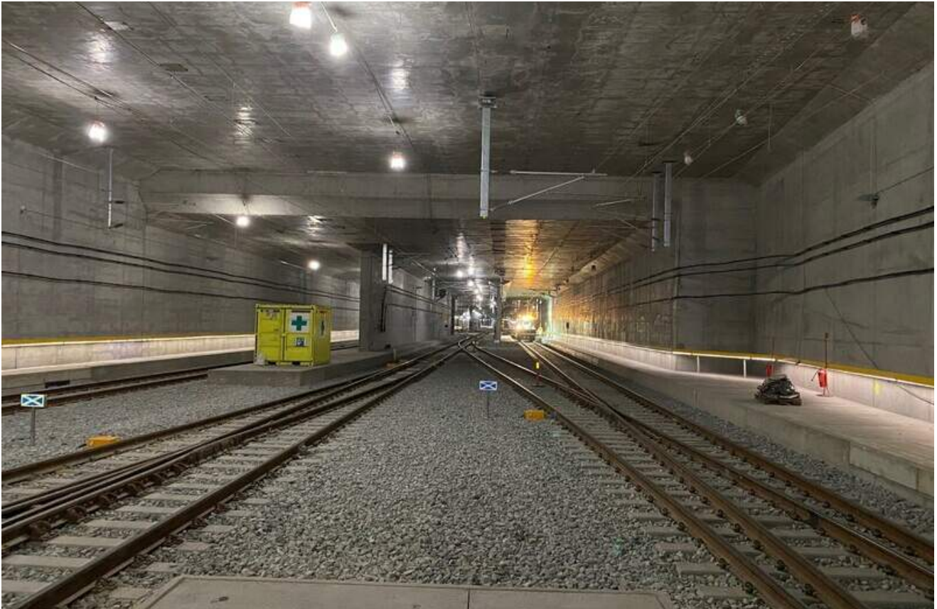
KONGSHAVNTUNNELLEN: Ny jernbanetunnel for inngående Østfoldbanespor. Tunnelen er sammenkoblet med en ny betongtunnel i Klypen. Foto: Bane NOR
