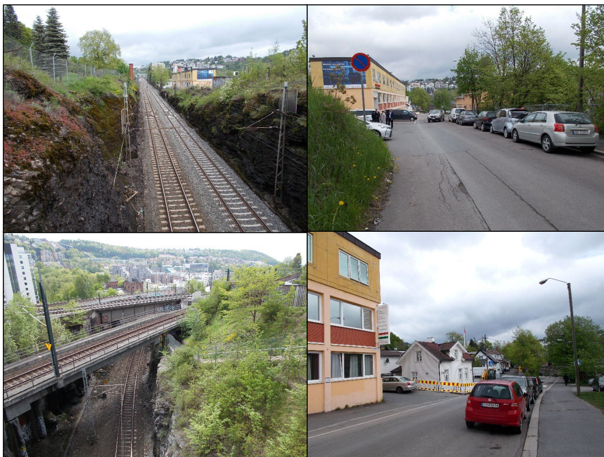
Figur 4-5 Bilder fra planområdet. Med klokken, øverst fra venstre: Hovedbanen sett mot øst, på nordsiden av Enebakkveien; Enebakkveien sett mot øst, næringsbygget i Enebakkveien 36B til venstre på bildet; jernbane som krysser i flere nivåer, sett mot sør fra Gjovikbanens tunnelmunning; Enebakkveien sett mot øst, med vernet bebyggelse i nedre del.
