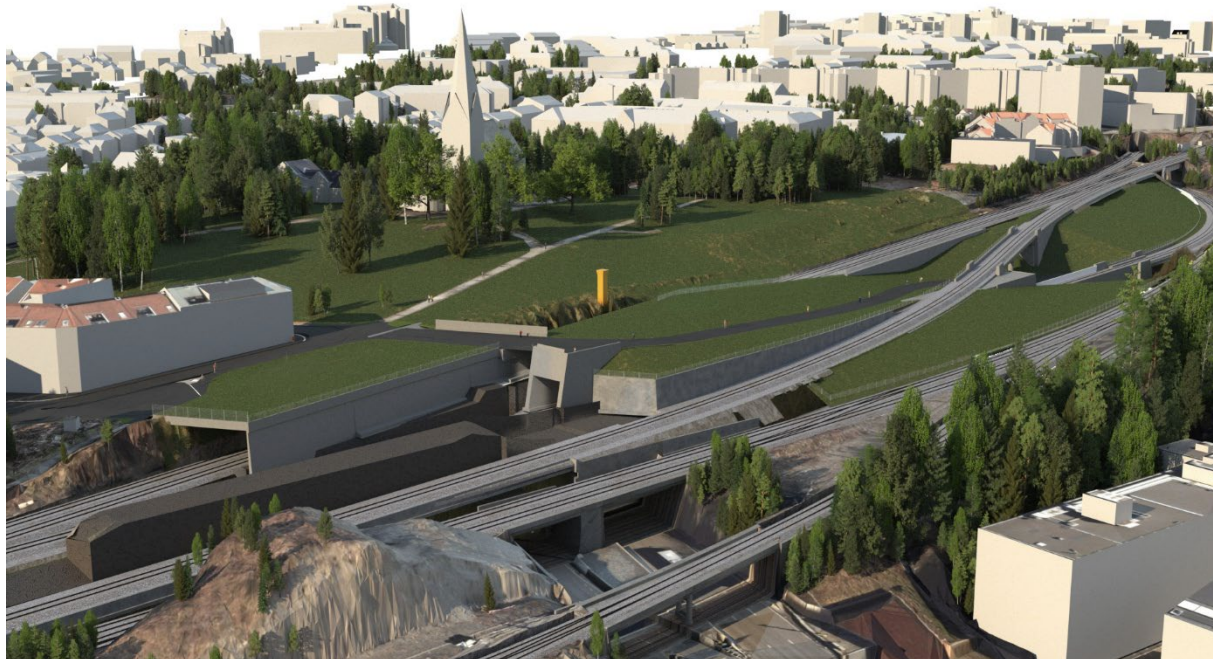
Figur 7-4: Modellutsnitt kort lokk sett mot nordøst. Det vil kunne gjøre «Enga torg» større og gi flere bruksmuligheter for dette punktet som knytter sammen Enebakkveien, Vålerengaparken og gangforbindelse fra Sankt Halvardsgate og Klosterenga.
