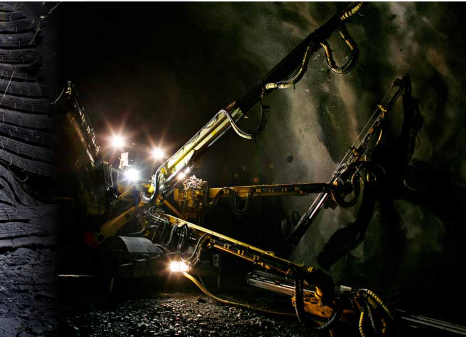
Forinjeksjon i fjellet. Med bruk av tunnelrigg bores det lange hull som fylles med tettemasse før sprengning
