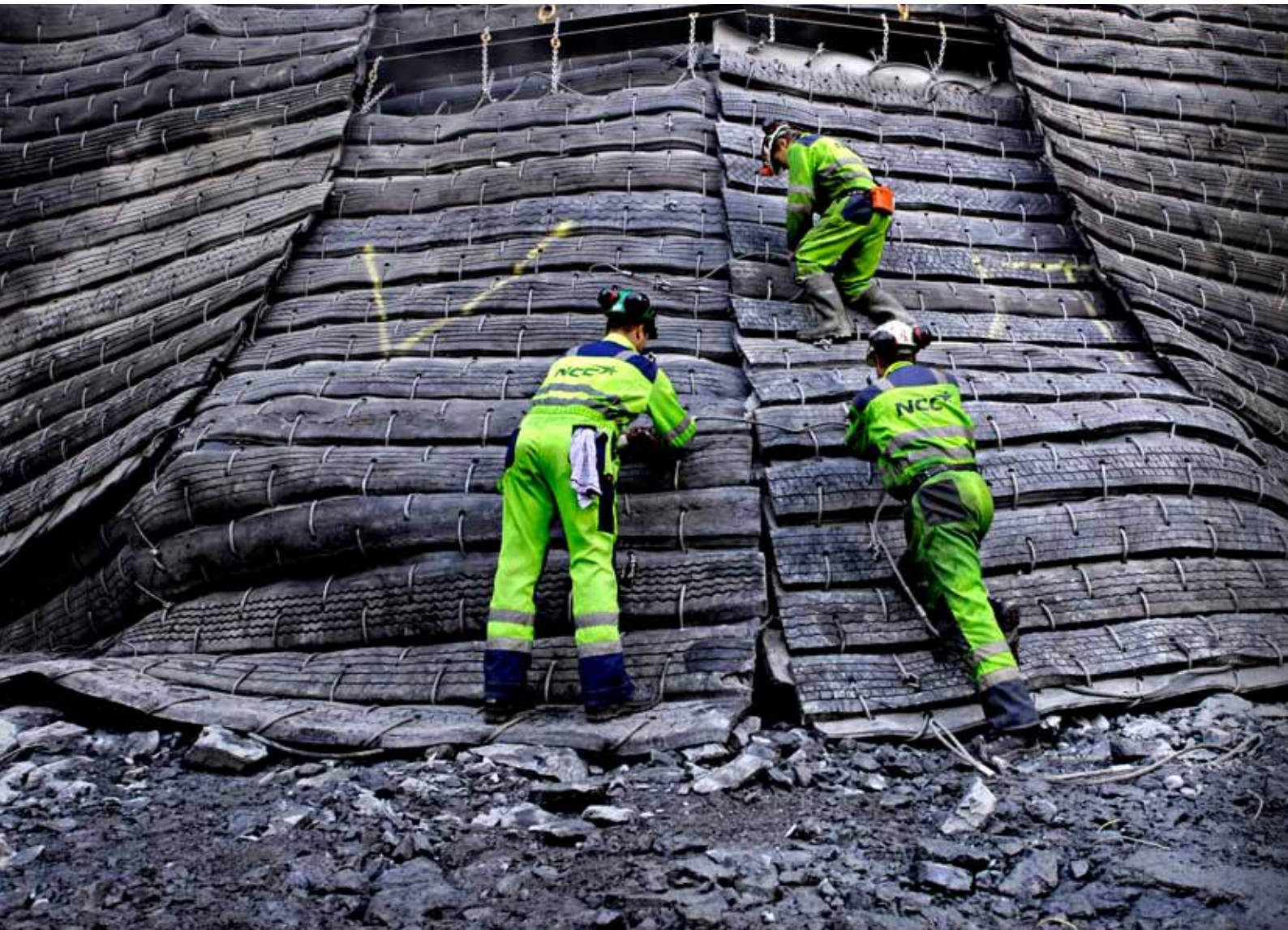
Oppstart av tunnelarbeider. Anleggsarbeidere legger ut matter som skal hindre steinsprut ved sprengning ute i dagen. Her forberedes den første salven på tverrslaget for jernbanetunnelen mellom Lysaker og Sandvika i 2007
