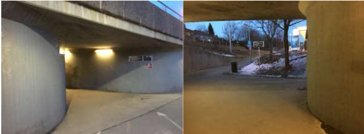
Figur 10: Avrundete hjørner i gang- og sykkelkulverten under Sørkedalsveien i Smestad.
