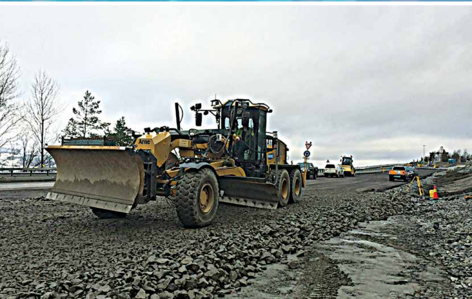
Noe asfaltarbeider gjenstår mellom Ørbekk og Splitten før siste del av E6 åpner i juni. (Foto: Fellesprosjektet E6 Dovrebanen.)
