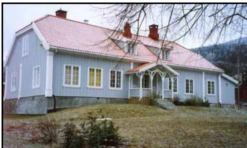
Hovedhuset på Ulvin, sett fra gårdsveg ved bru over E6 ( Foto: NIKU – 2002).
