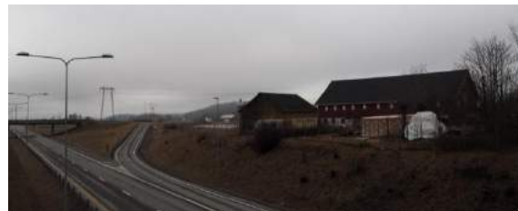
Figur 3-8: Kopstadkrysset, sett fra bru over E18.
