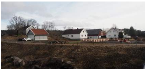
Figur 4-9: Råen. Til venstre i bildet, plassert i øst-vestlig retning, ses et våningshus fra tidlig 1900-tall (SEFRAK ID 07160204052).
