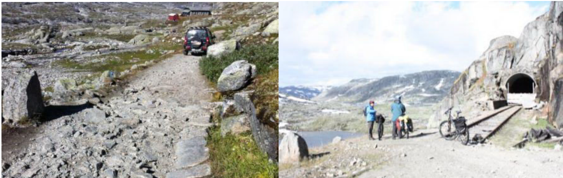
Tv: Vegen ned mot Grjøttrust vaktarbustad. Th: kryssing av gamlelinja ved Grjøttrust.
