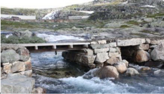
Tv: bru på skjener og hellebru, Hallingskeid.
