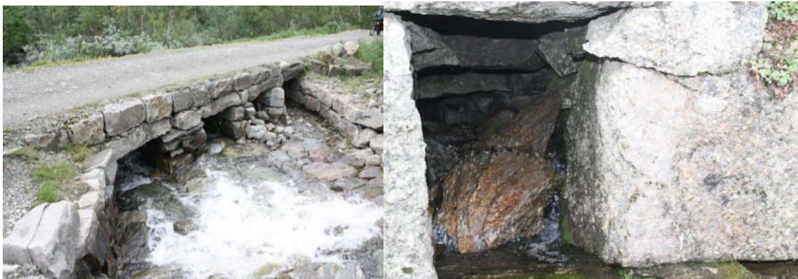
Tv: Restaurert stikkrenne.
