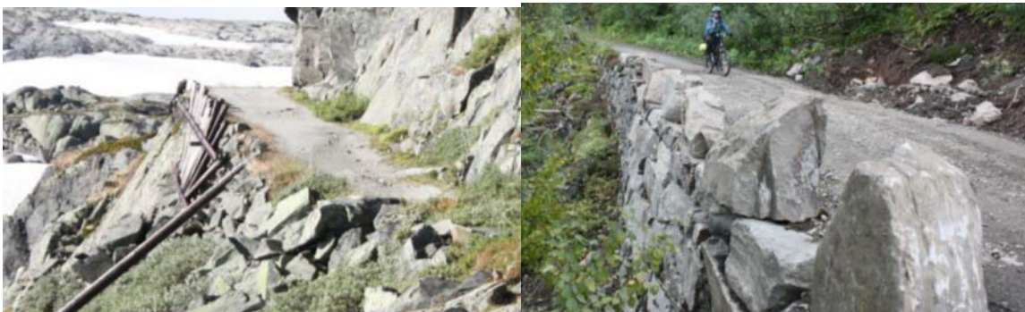
Tv: Mur reparert på 1980-talet. Th: Mur reparert 2015, merk stabbesteinane.
