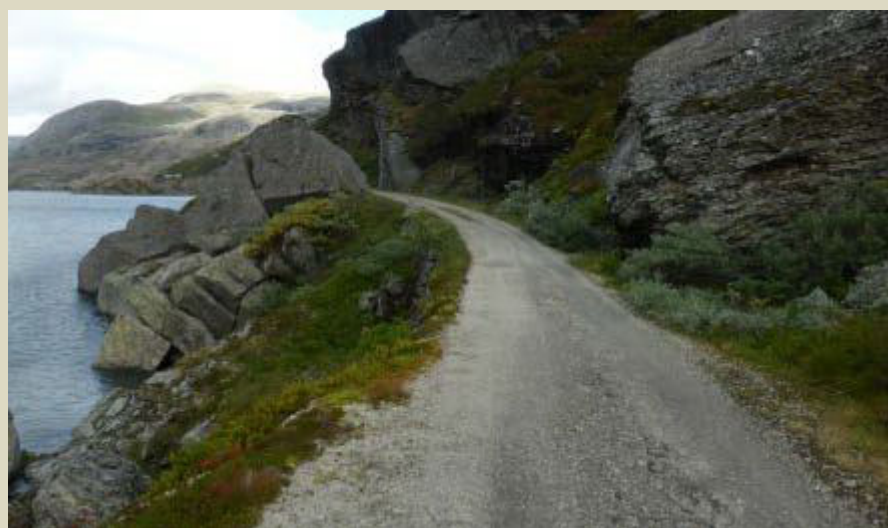
Element nr.20: Hallingskeid-Kleven undergang
