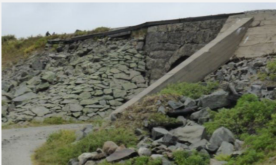
Element nr. 3 Undergang Finsesvingen
