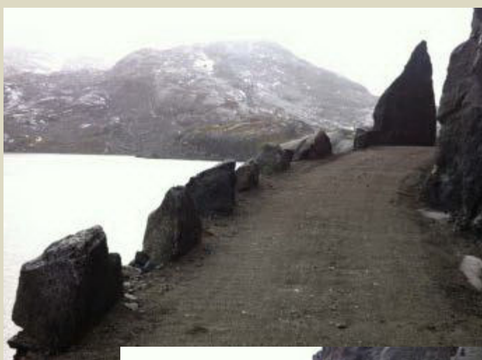
Element nr. 16: Mur ved Høgda
