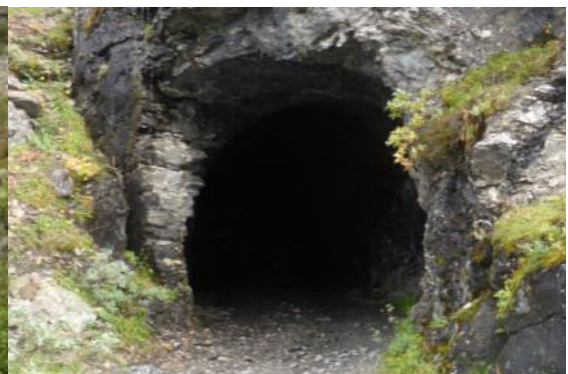
Th: Tunnelen under banen ved Kleven bru
