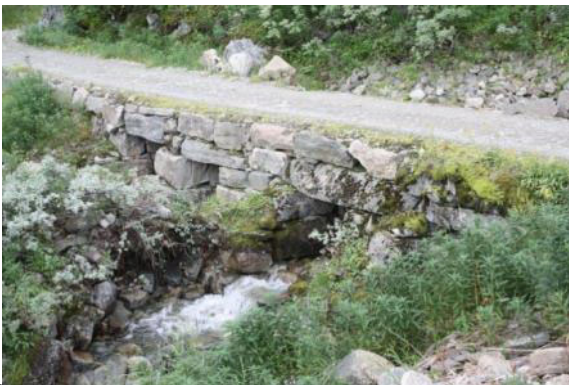
Tv: Rehabiliterert stikkrenne.
