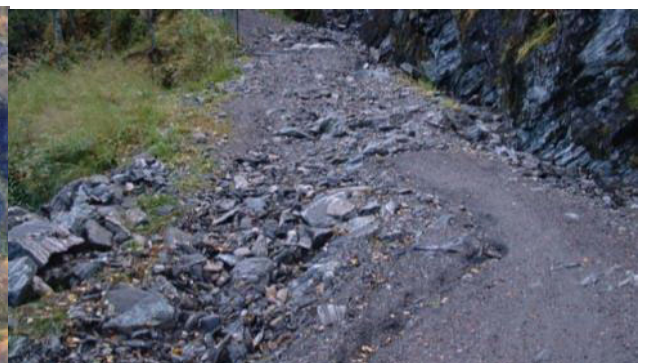
Th: Før rehabilitering.
