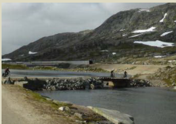
Element nr.14: Bru ved Lågheller
