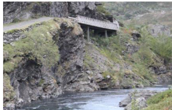
Th: Bru til erstatning av utrasa mur.
