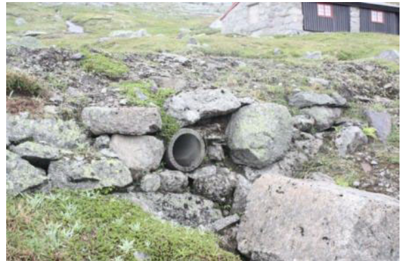
Tv: Døme på kollapsa stikkrenne. Th. Tidlegare nød reparasjon av ei anna.
