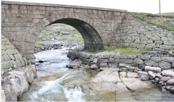
Element nr. 1 Bru over Finseåa
