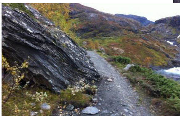
Tv: Klevagjelet. Tv. blokk på sig ned og inn i vegen.
