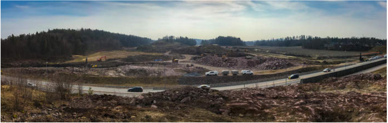
Her kommer den nye stasjonen. (Foto: Terje Walle, Bane NOR)
