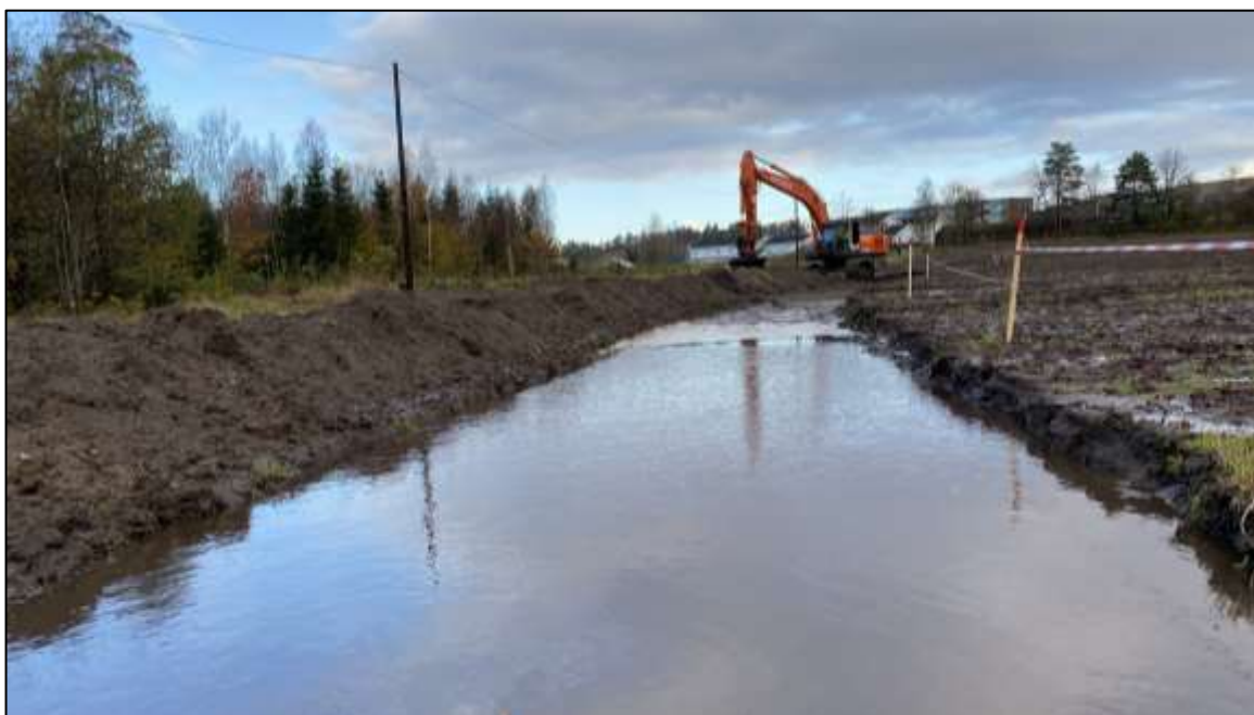
Godvær i sikte. Overvannet ledes ut av sjakta og kokegropene A1, A2 og A3 dukker foran gravemaskinen. Mot nord.
