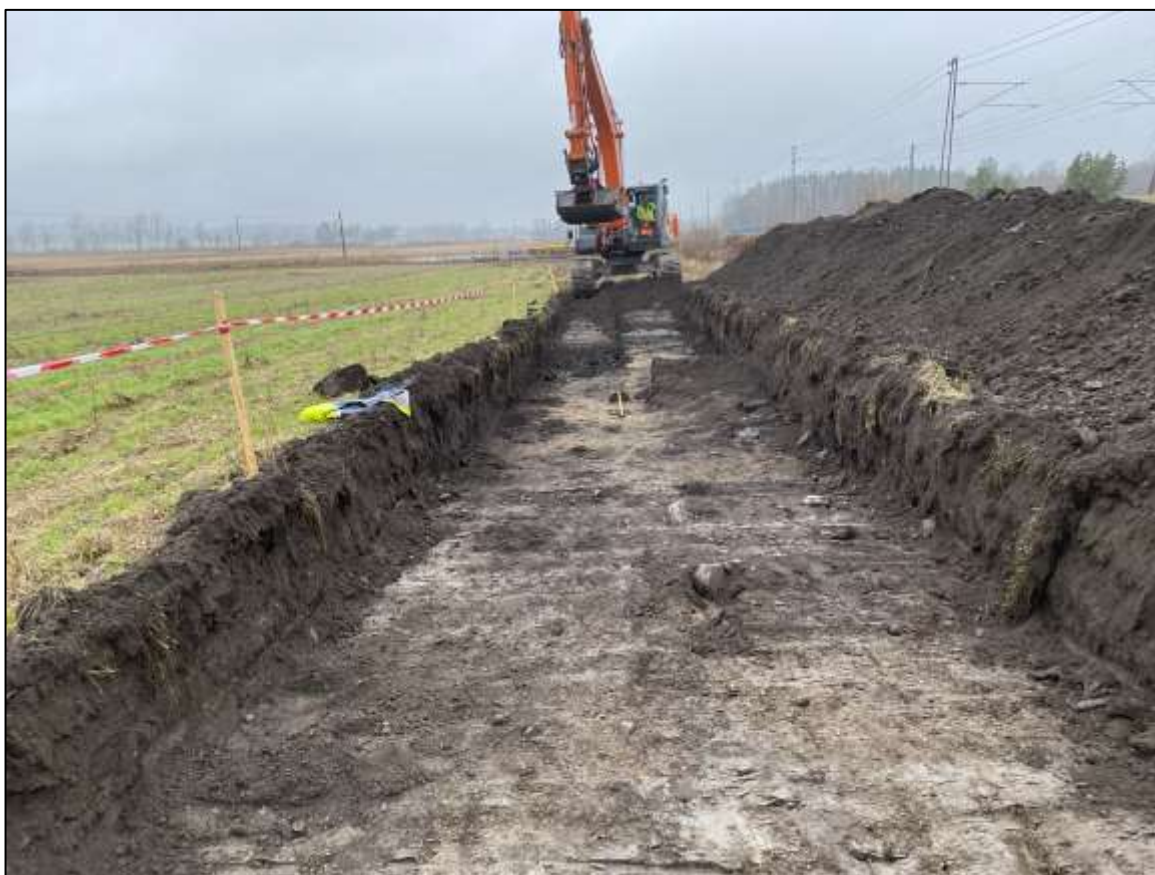
Lokalitet 3 og sjakt 21, med dyrkingslag A21, etter at mye av dyrkingslaget er fjernet i sjakta. Under dyrkingslaget dukket det opp forhistoriske groper. Vi fant keramikkskår både i dyrkingslaget og et par av gropene. Mot nordvest.
