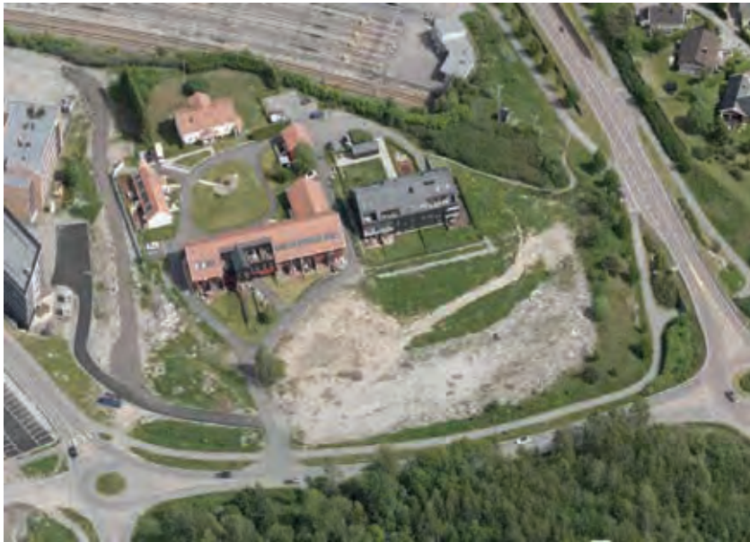
Dagens situasjon (Skråfoto av tomten fra 2021)
