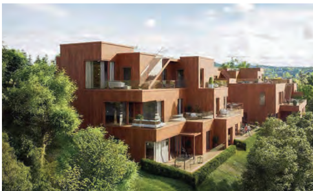
Leangveien, Asker - Code arkitektur - under bygging
