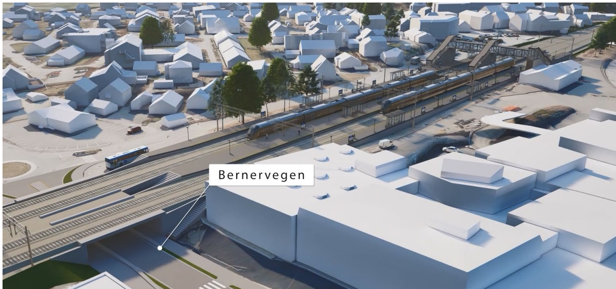
Figur 23. Nærbø stasjon med ny adkomst til plattform over sporene samt fra Bernervegen. For å avvikle økt trafikkmå stasjonen ha spor for både forbiskjøring samt vending av tog. Stasjonen planlegges derfor med 4 spor.
