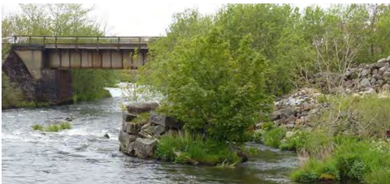
Figur 31. Jernbanen krysser Hååna. Foto: Bane NOR v/ Börje Karlsson.
