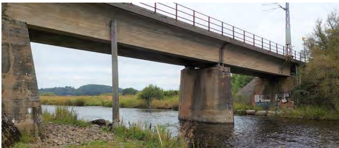
Figur 49: Jærbanen over Figgjovassdraget. Foto: Bane NOR v/ Börje Karlsson.
