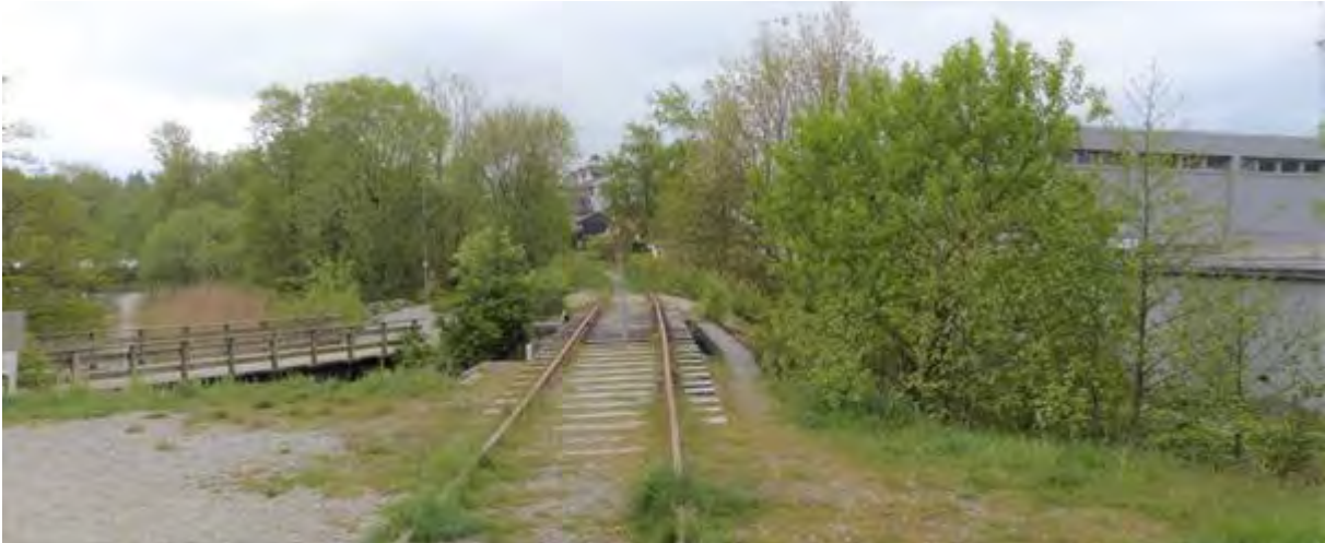
Figur 54: Ålgårdbanen ved Ganddal stasjon. Foto: Bane NOR v/ Börje Karlsson.
