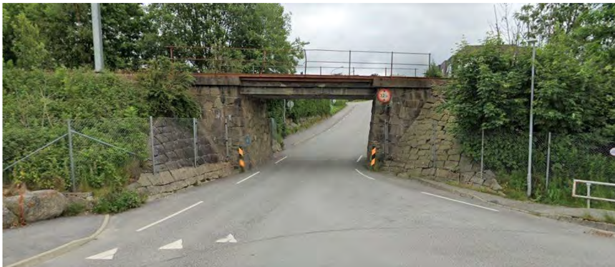
Figur 41. Hognestadvegen ved Nubben krysser under banen. Foto. GoogleMaps.
