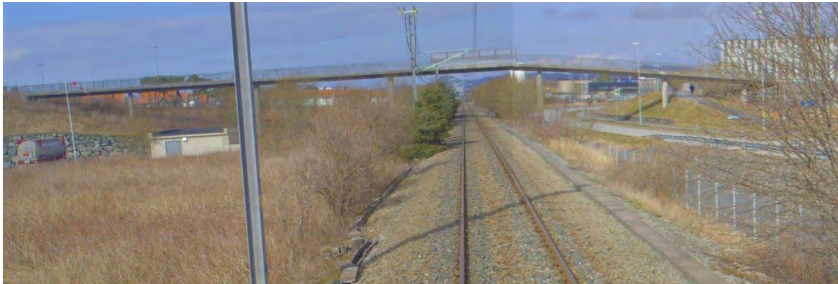
Figur 52: Overgangsbru Ganddal. Foto: Bane NOR.
