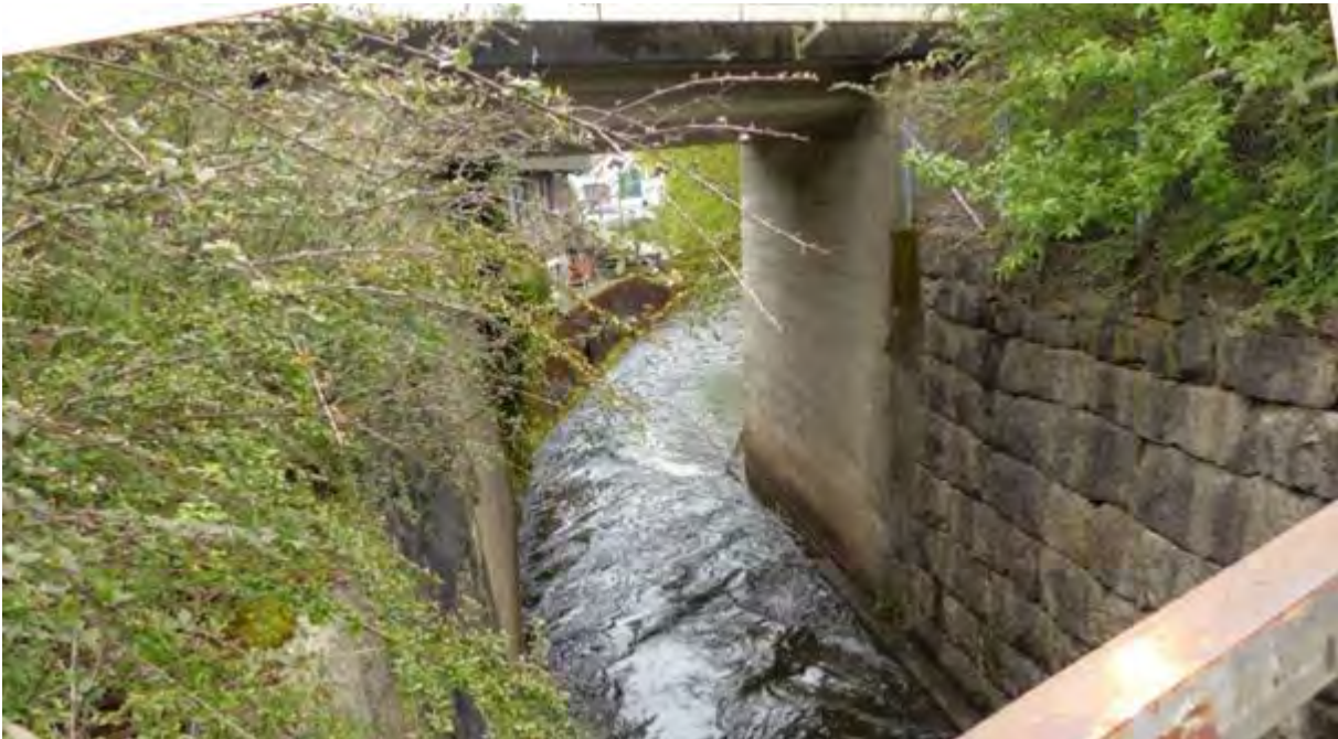
Figur 55. Jernbanebru over Storåna med Ganddal. Foto: Bane NOR v/ Börje Karlsson.
