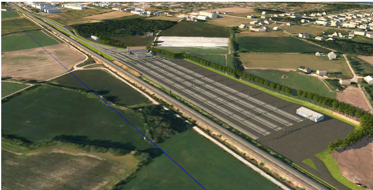
Figur 15 Oversikt over hensettingsanlegget sett fra sør. Adkomst via Eskelundvegen vises til høyre i bildet.
