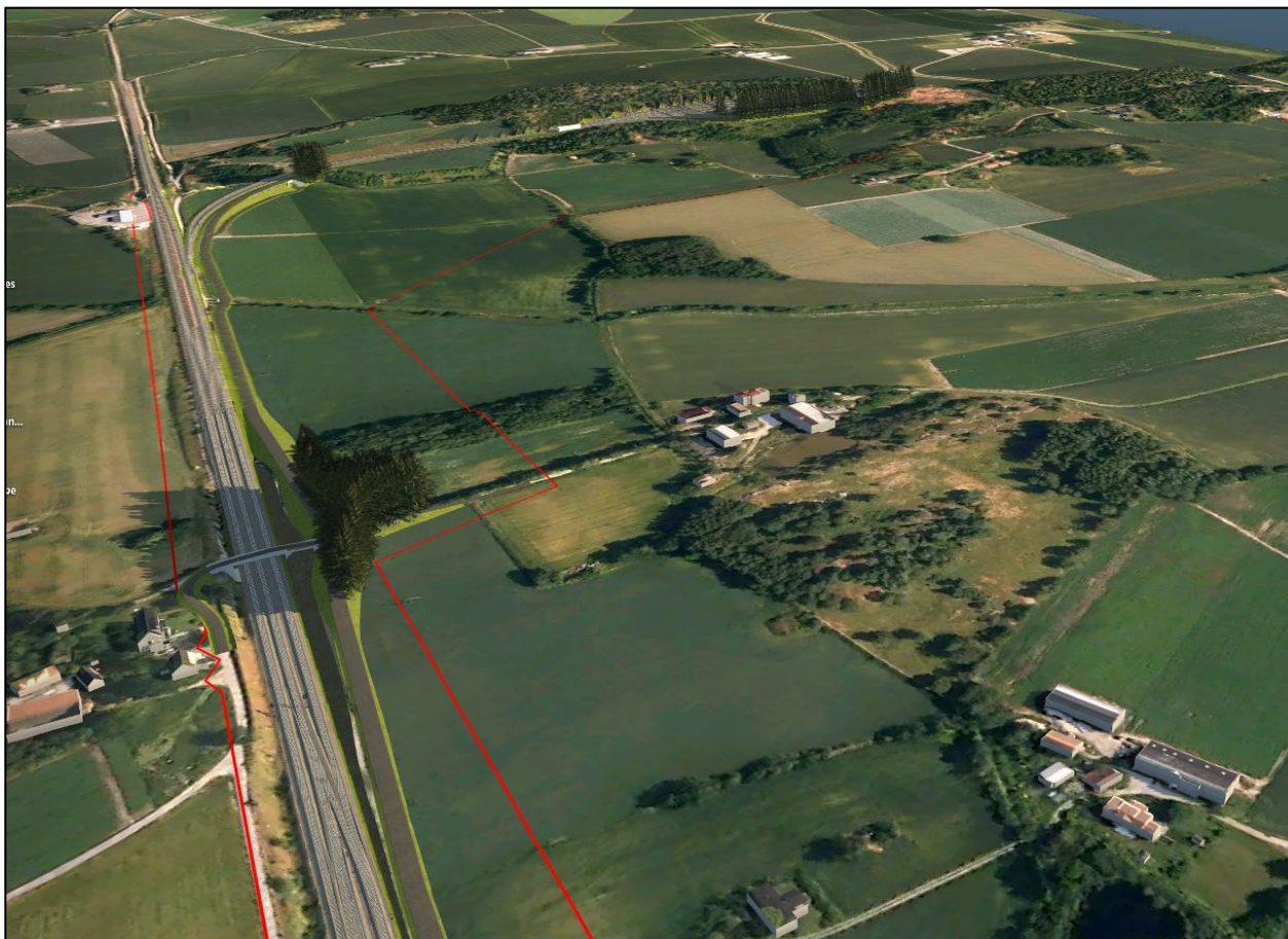
Figur 17 Oversiktsbilde fra nordvest viser ventespor og ankomstspor inn mot hensettingsområdet som ligger øverst i bildet. Adkomstvegen ligger langs høyre side av sporet.
