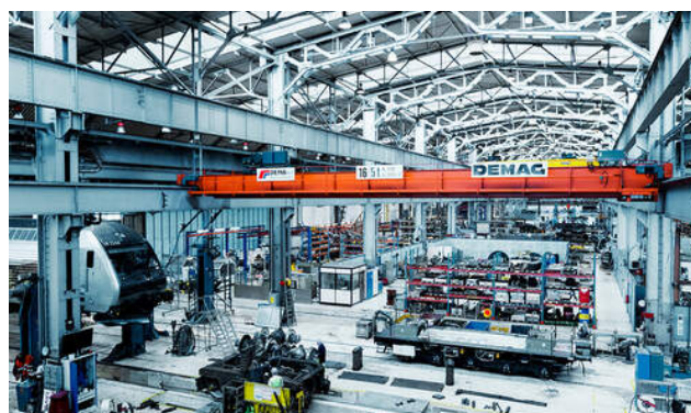
Energieffektiviserings tiltak på verkstedene har gitt betydelig reduksjon i energiforbruket, her fra Grorud. Foto: Sune Eriksen
