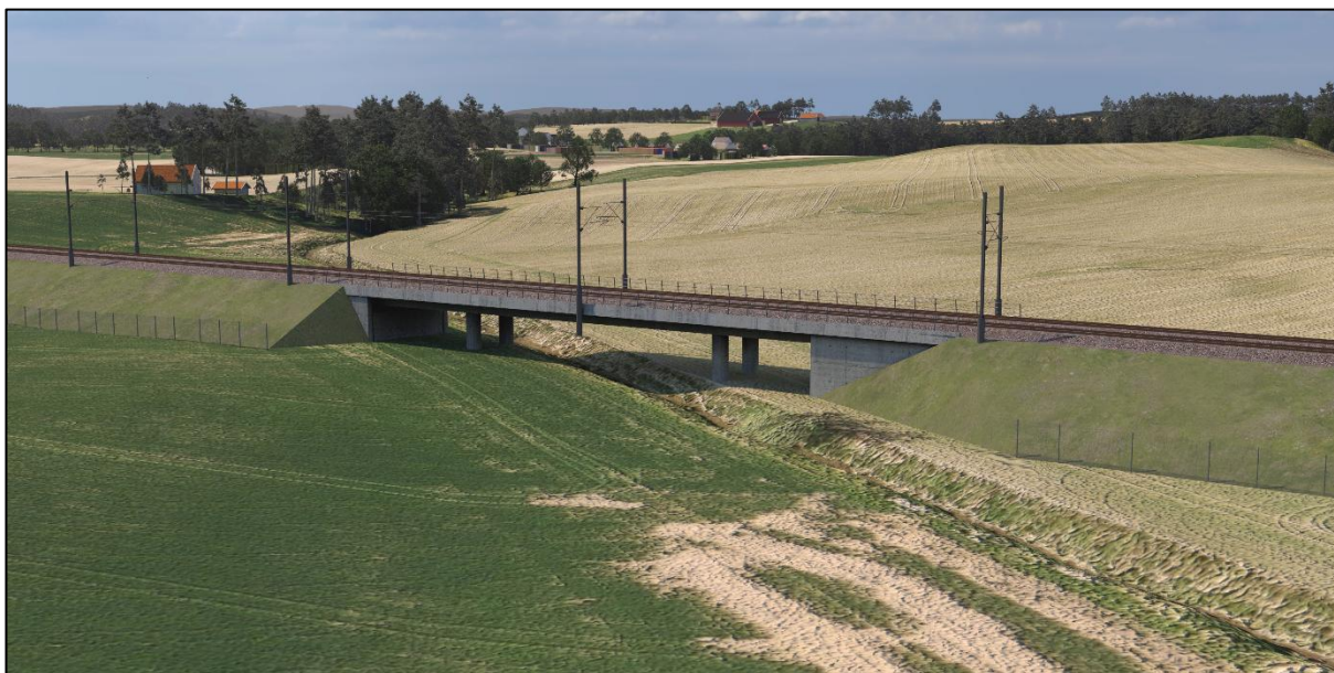
Figur 6-32: Alternativ L1 (senket linje) - Illustrasjon av Engsbekken jernbanebru sett mot sør. Løkenveien 30 kan ses øverst til venstre i illustrasjonen. Bekkekryssingen får en annen utforming enn i L1 på grunn av at jernbanelinjen er senket.
