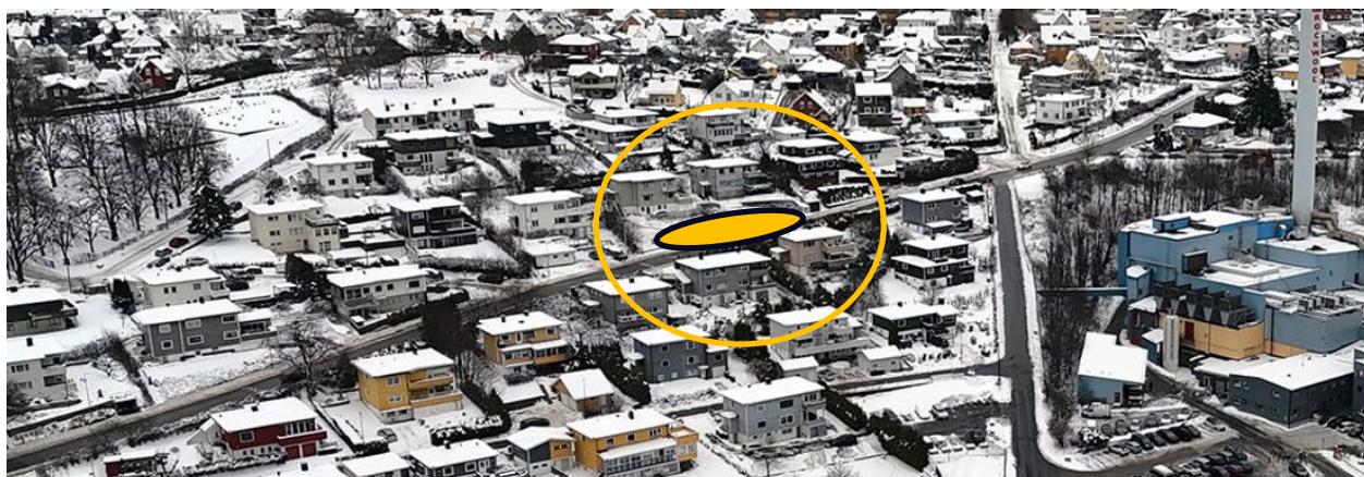
Ekstra grunnundersøkelser gjøres i dette område ved Fjordveien. Foto: Bane NOR
