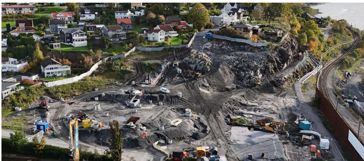
Kleberget, hvor vi forbereder å lage en åpning (forskjæring) inn til tunnel. Foto: Bane NOR.
