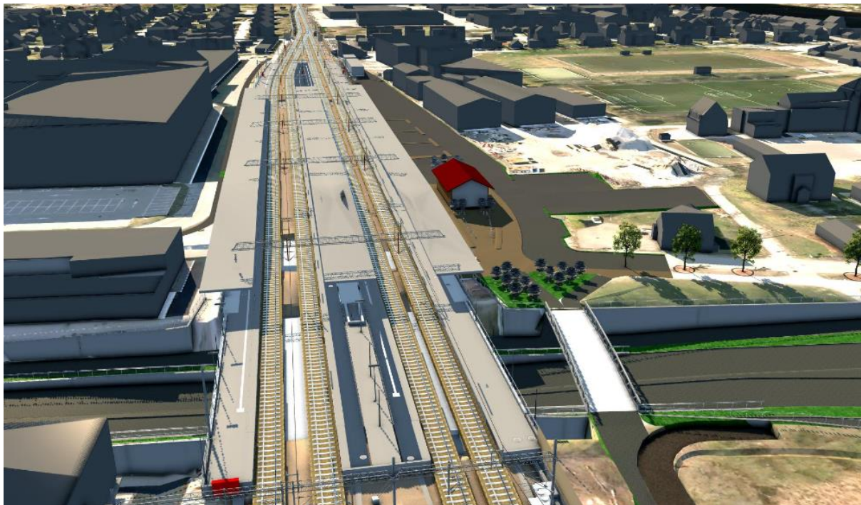
Figur 11: Ny stasjon ved Gulsbogen med 4 spor til 350 m lange plattformer. Ny p-plass ligger på nordsiden av stasjonen. Baker Thoens allé er vist som en 4 feltsvei og med brede gang- og sykkelvei på hver side.
