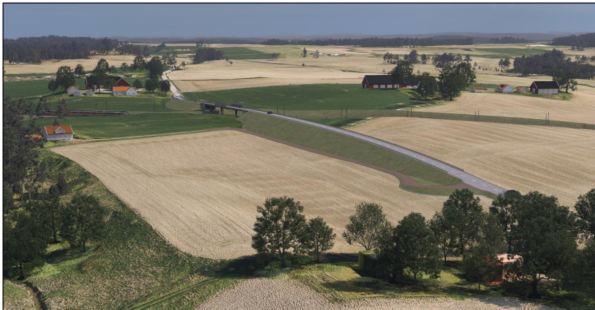
Figur 6-8: Alternativ L0 - Illustrasjon av tiltaket, sett i fugleperspektiv mot nord. Ny avgrening Østre linje krysser under Løkenveien (fv. 1370), som heves i forhold til terrenget i bru over jernbanen. Atkomsten til Vang gård (i øvre høyre del av illustrasjonen) legges om til nordsiden av ny jernbane. Atkomsten til Løkenveien 30, på sørsiden av jernbanen, legges om.
