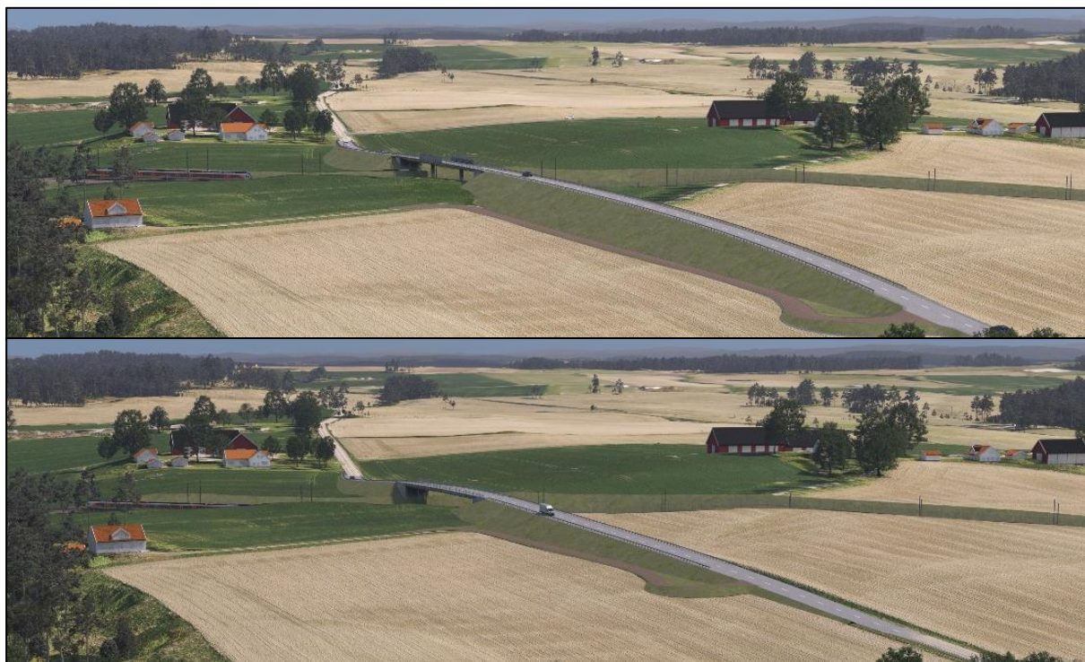
Figur 7-4: Visualisering av forskjell mellom alternativ L0/L1 der Løkenveien krysser i bru over ny avgrensning Østre linje. Over: Alternativ L0 . Under: Alternativ L1 . Oversiktsillustrasjon, sett i fugleperspektiv fra Veslevang gård i retning nord.
