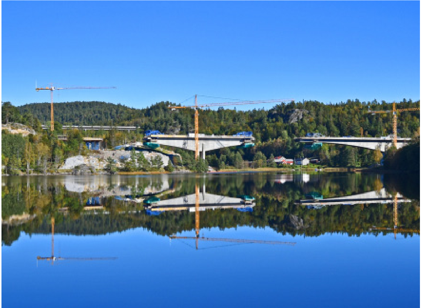
Foto: Terje Walle. Hallevannetbrua tar form ved gamle E-18 ved Vassbotn.
