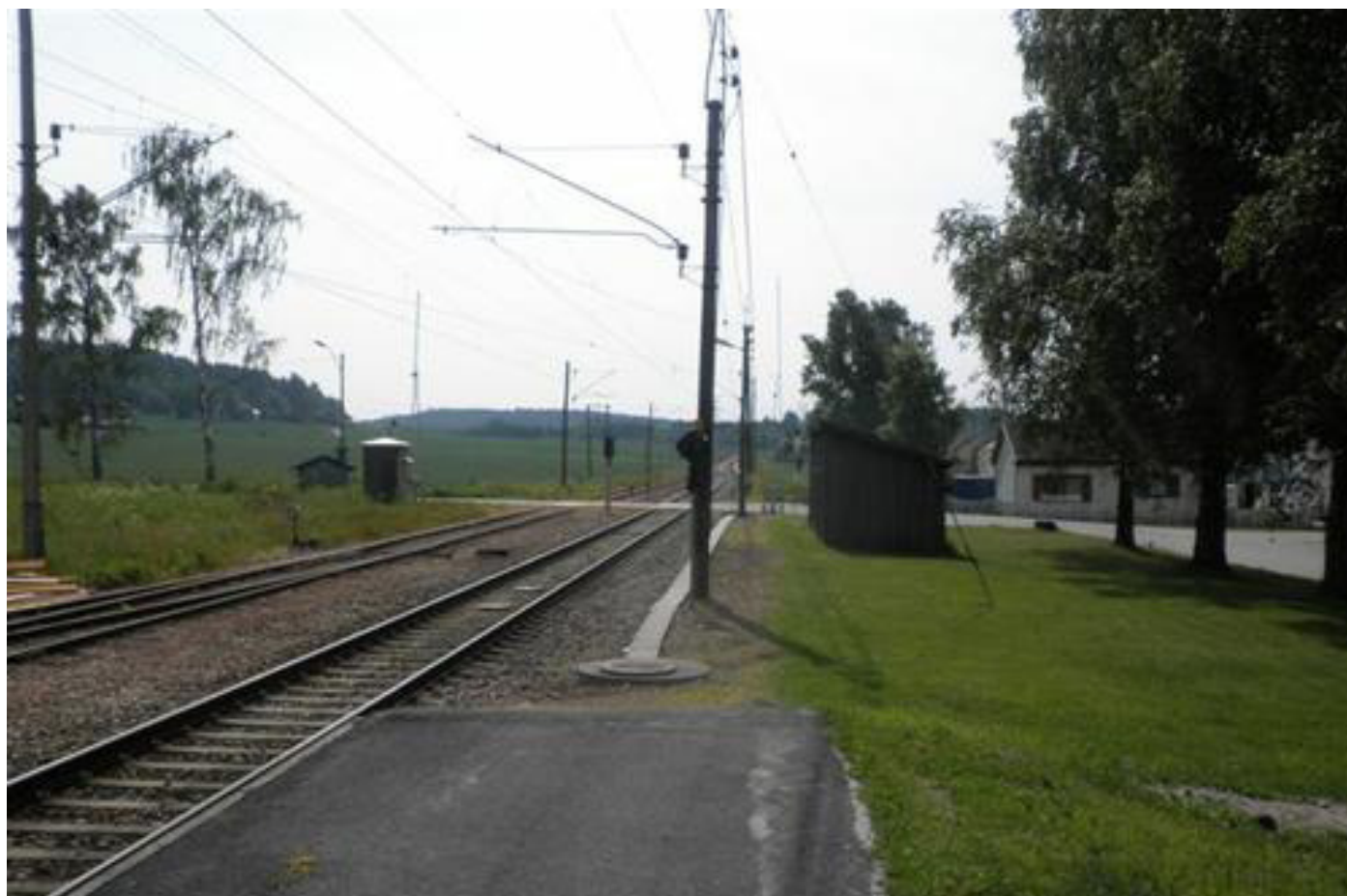
Kråkstad stasjon står oppført i Nasjonal verneplan for kulturminner for jernbanen. Stasjonsbygning, privet og sykkelstativ er listet opp i verneplanen.
