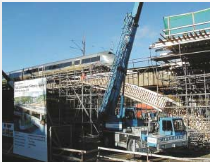
Flytoget passerer over bueforskaling, Sandviksbruene. (Foto: Harry Korslund)
