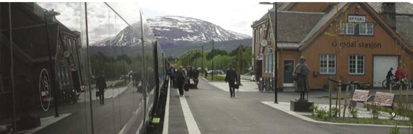
Oppdal stasjon, Dovrebanen. Foto: Njål Svingheim
