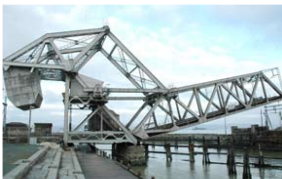
Skansen jernbanebru i Trondheim er fredet av Riksantikvaren. Foto: Arvid Bårdstu
