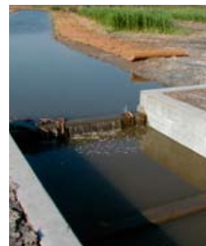
Ny kanal – fisketrapp i kulverten ved fabrikkområdet Råde. Foto: Kjell Gulvik
