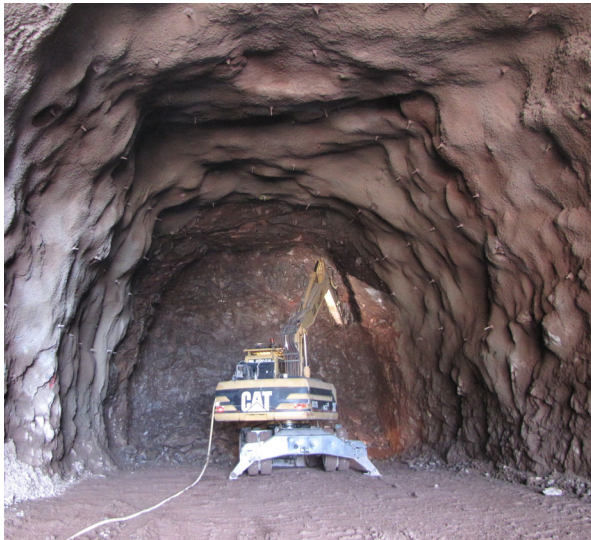
(Det begynner å ligne en tunnel. Tverrslagstunnelen i Kjellelia har passert 75 meter. Total lengde ned til hovedtunnel er 170 meter.
