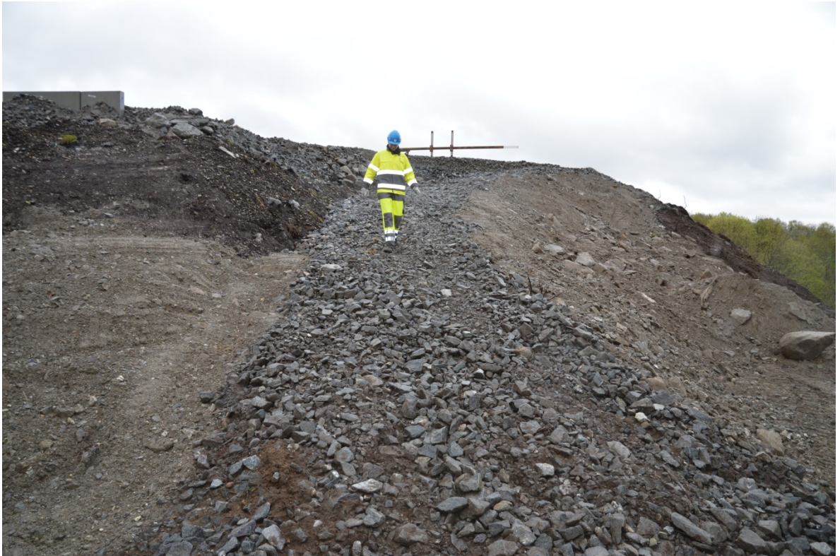
Gangsti fra nord: Prosjektleder Ingunn Ramdal tester gangstien og kan forsikre alle om at den blir grei å gå på når alle lag med masser er fylt på. Gangstien planlegges også ferdig til 1. juli som resten av det nye jernbaneanlegget. Foto: Anne Rognes, Jernbaneverket.
