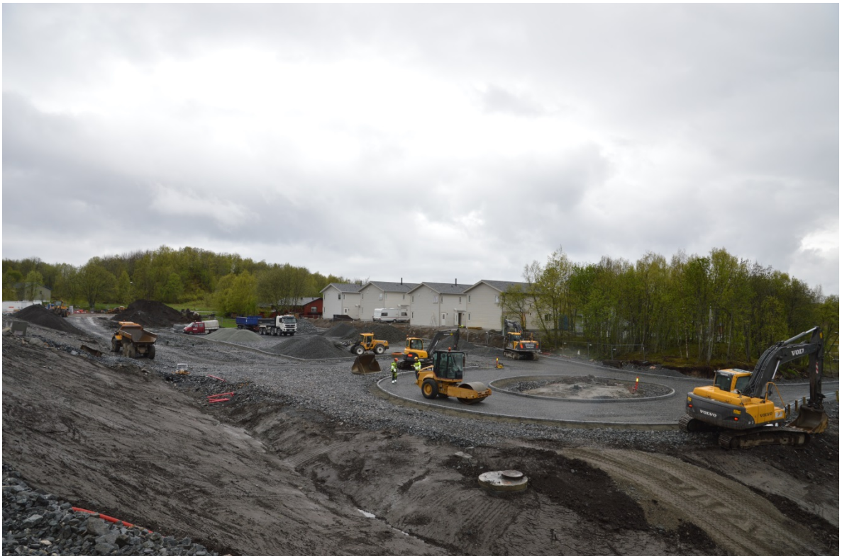
Konturen av anlegget: Arbeidet med parkeringsplassen og rundkjøringa ved Tverlandet holdeplass har kommet langt. Foto: Anne Rognes, Jernbaneverket.
