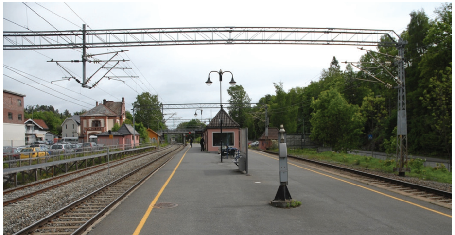
Stabekk stasjon blir nå anleggsområde. Kundeparkeringen stenges i anleggstiden. (Foto: Gøran Aas)
