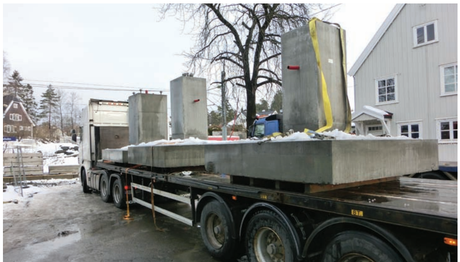
Fundamenter til kontaktledningsmaster fraktes inn til Blommenholm stasjon. (Foto: Gro Elden)
