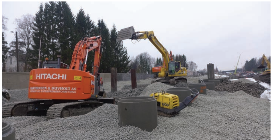
Tilbakefylling av masser på stasjonsområdet. Den varslede forsinkelsen av signalanlegget påvirker ikke de øvrige anleggsarbeidene. (Foto: Gro Elden)
