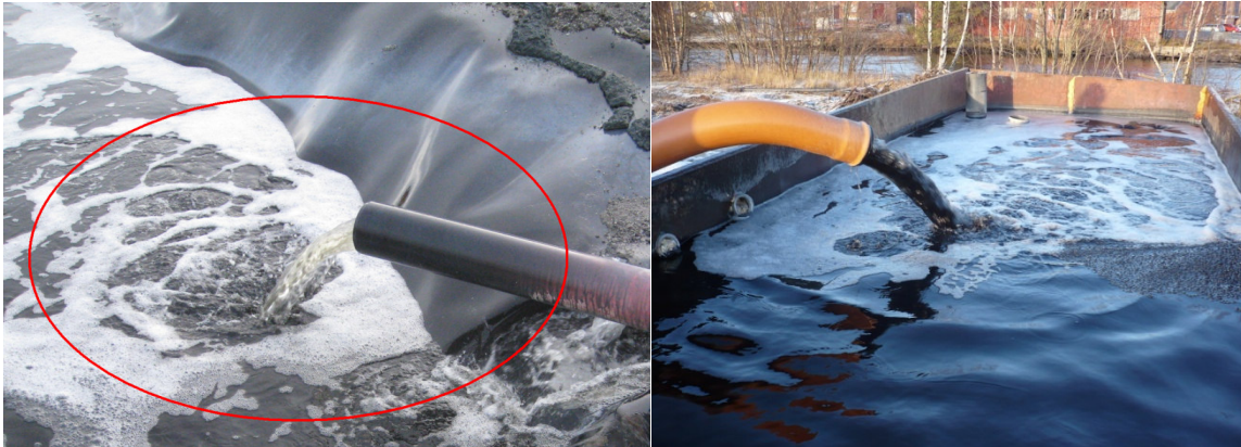
Figur 1: Lensevann ved sedimentasjonsbassenget ved Halden Driftsbanegård, hhv innløpsvann og utløpsvann
