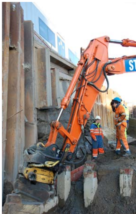
Her pågår arbeid like ved jernbanen i Sandnes sentrum. Et lokaltog kan skimtes over spuntveggen. Foto: Jernbaneverket, desember 07
