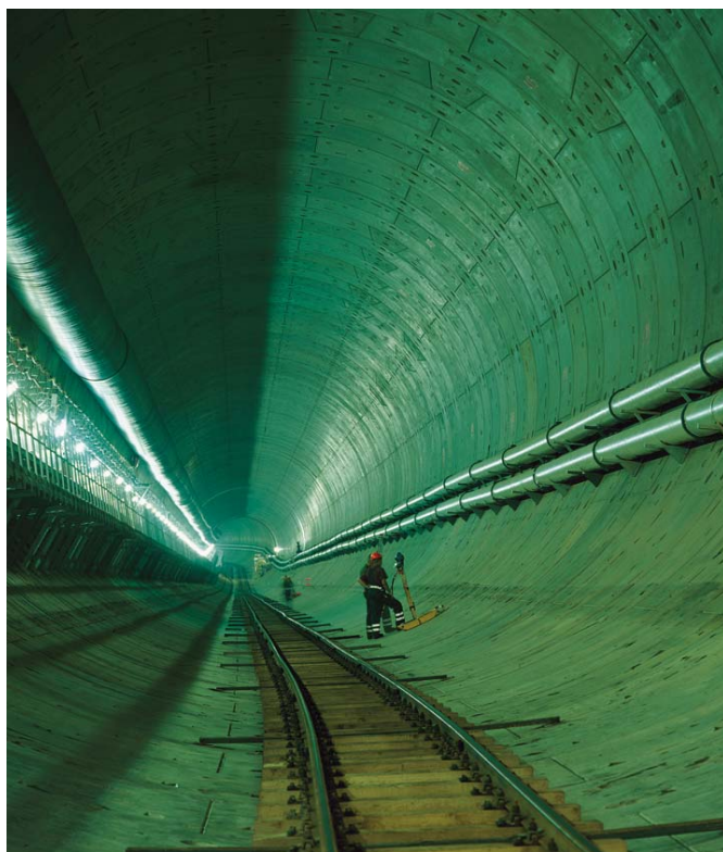
Figur 1.2: Fullprofilboret tunnel med diameter 14,2 m, utforet med betongsegmenter.
