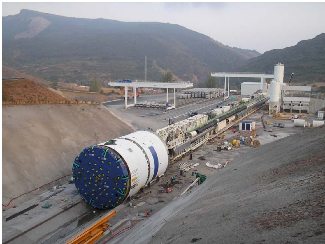
Figur 8.2: Eksempel på dobbeltskjoldmaskin med tilhørende bakrigg. Bildet viser også en del av tilriggingen samt lager for betongsegmenter.
