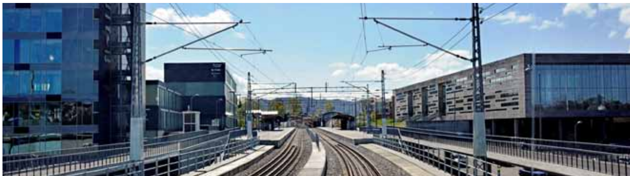
Dobbeltspor Sandnes-Stavanger. Foto: Hilde Lillejord/Jernbaneverket
