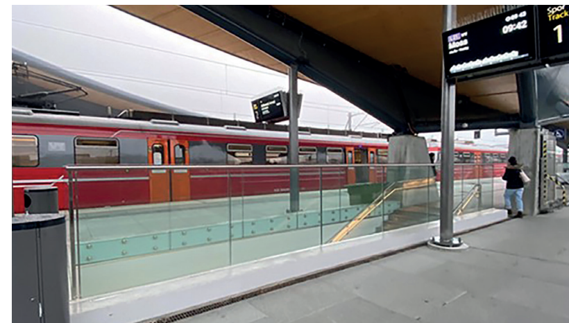
Sikkerhetsrekkverk av glass vil gi mer lys og luft til kulverten. Trappesystemet ligger under plattformtak. Glassrekkverk er brukt til kostnadsestimatet. Foto: Wichada T.
