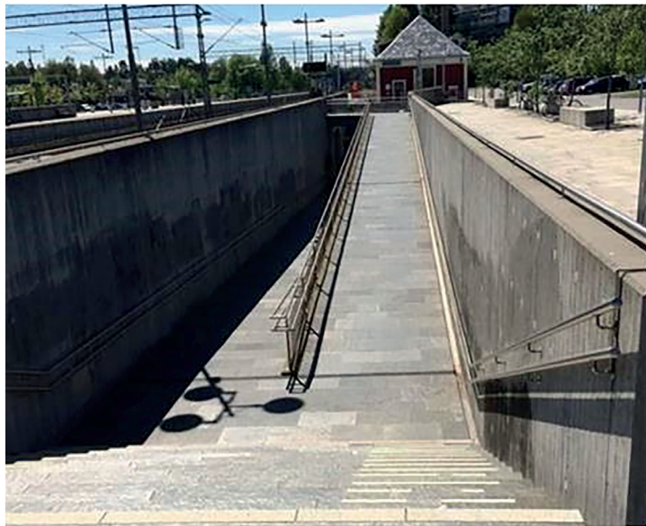
Sikkerhetsrekkverk av betong.
